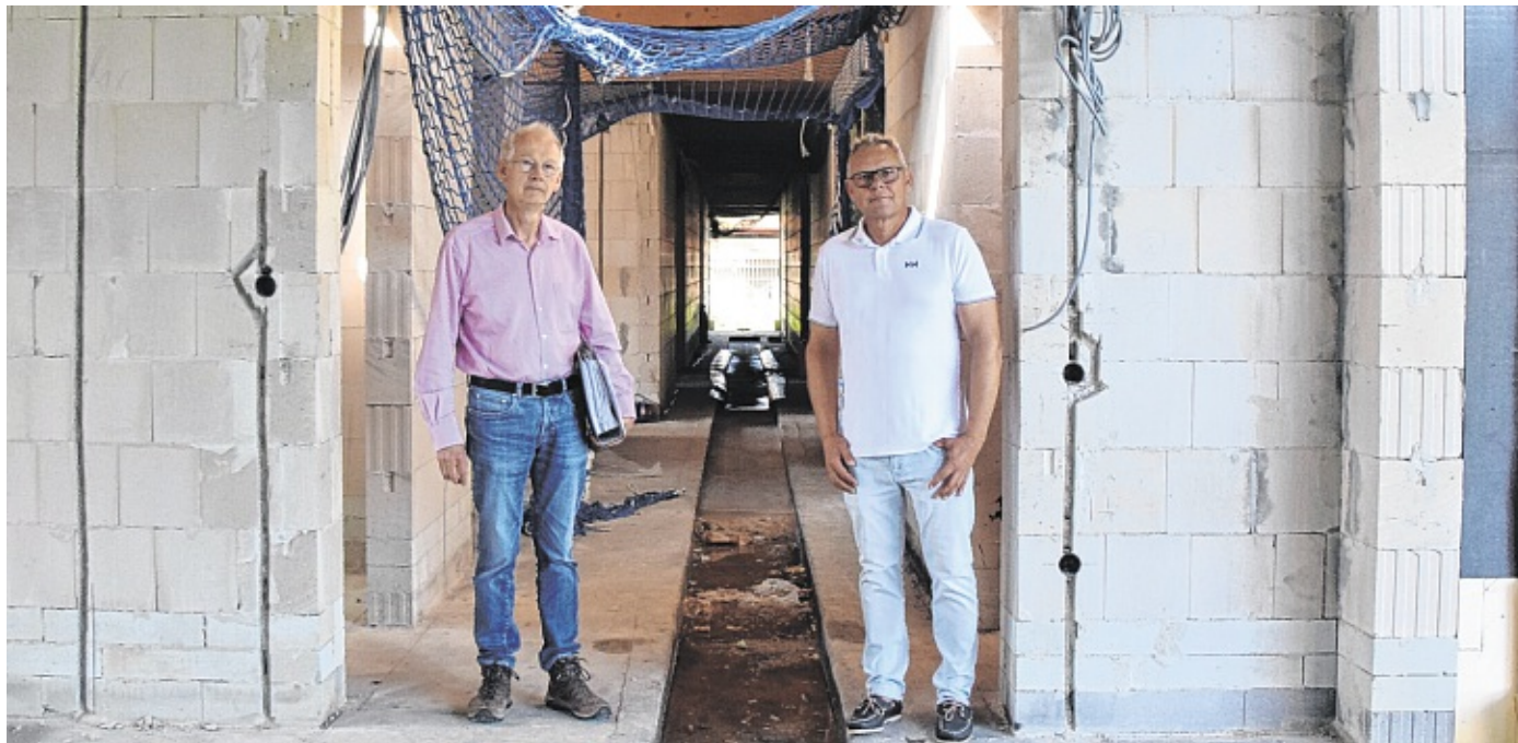
Noch stehen Gerald Kaapke (li.) und Kai Spranger im Rohbau von „Mehlbyhuus II“.
