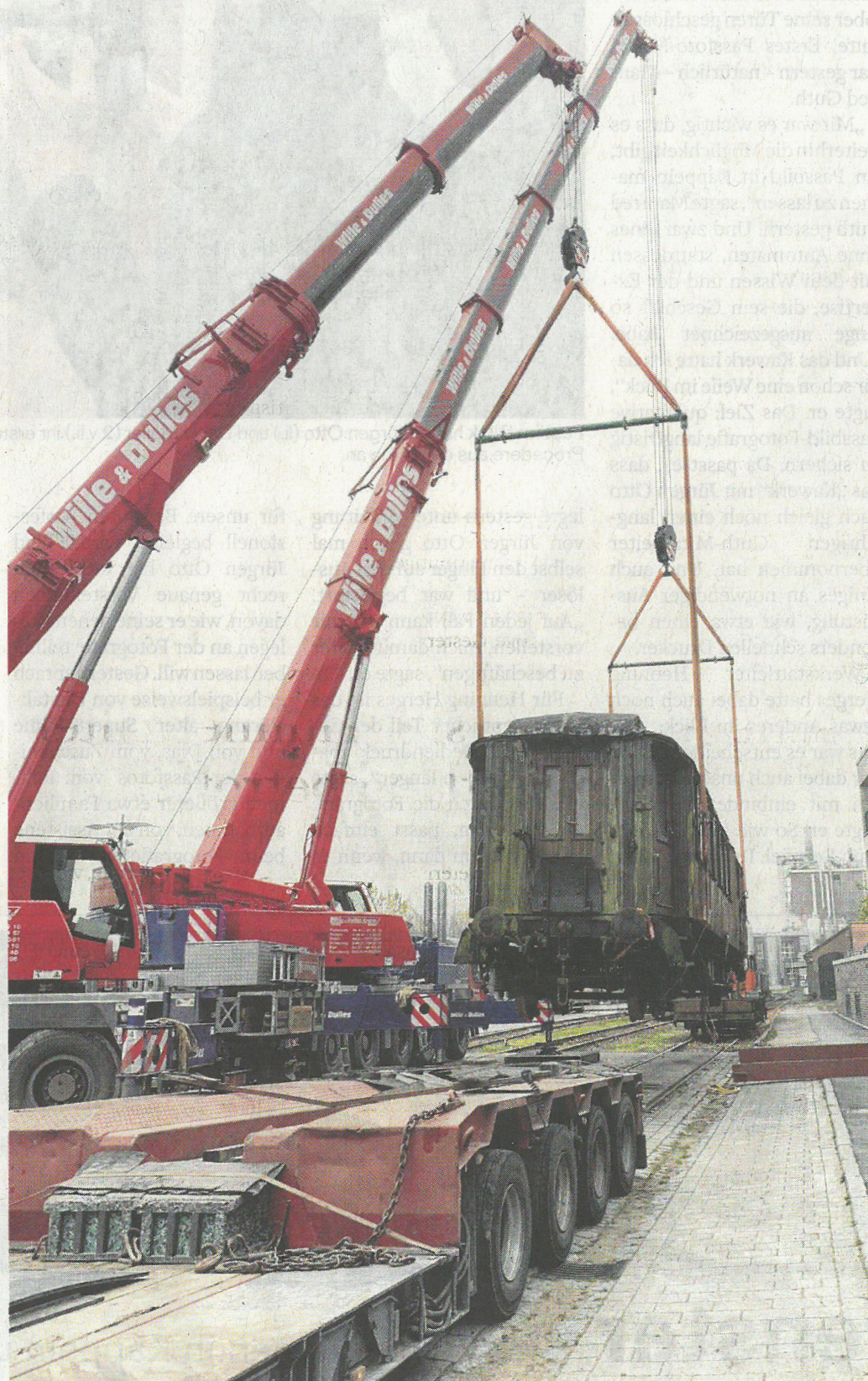
Spektakel am Südhafen: Gestern Vormittag hieven zwei Kräne den ausrangierten Waggon der Angelner Dampfeisenbahn auf einen Tieflader.
