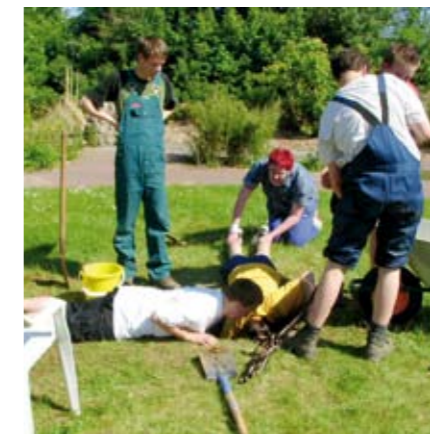
VORBEREITUNG DES GRUNDS UND AUFSTELLEN DES PFAHLS
