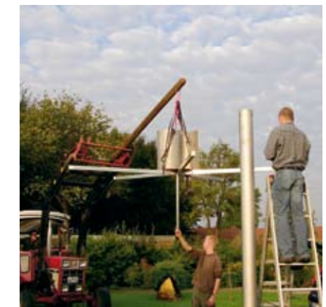
MONTAGE DES WINDRAD-KOPFES
