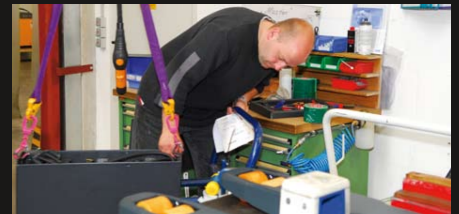
6 Einbau der Batterie
